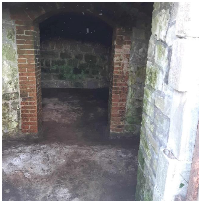
Obrázok 14 Interiér spodnej časti objektu po 3. dobrovoľníckej brigáde
