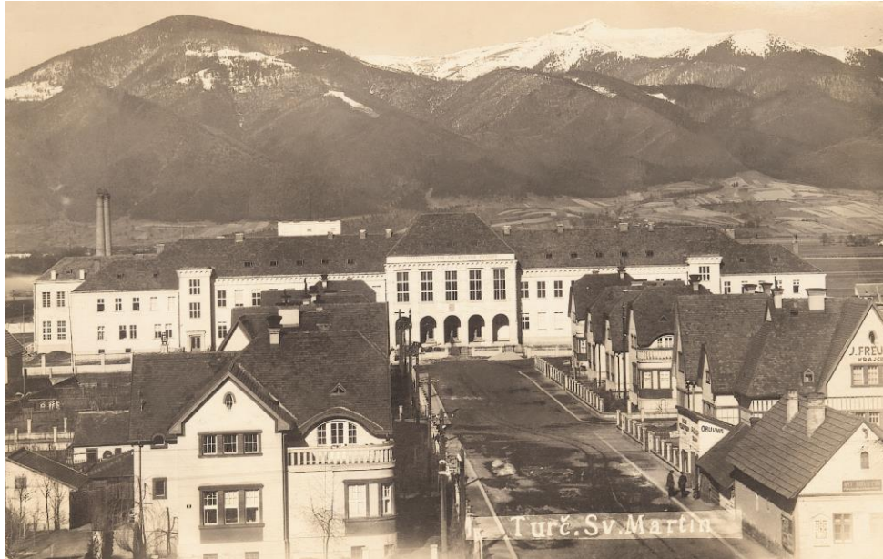
Obr. 5 Po ukončení dostavby Ústavu a jeho kolaudácií sa dokončila príjazdová cesta s chodníkmi
